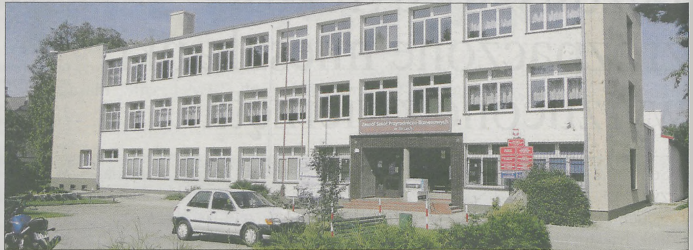
Jedną z inwestycji powiatu zakończonych przed nowym rokiem szkolnym jest termomodernizacja budynków szkoły w Tarcach
