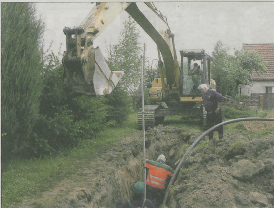
Najwięcej w tym roku gmina Kotlin wyda na budowę kanalizacji w Wilczy
