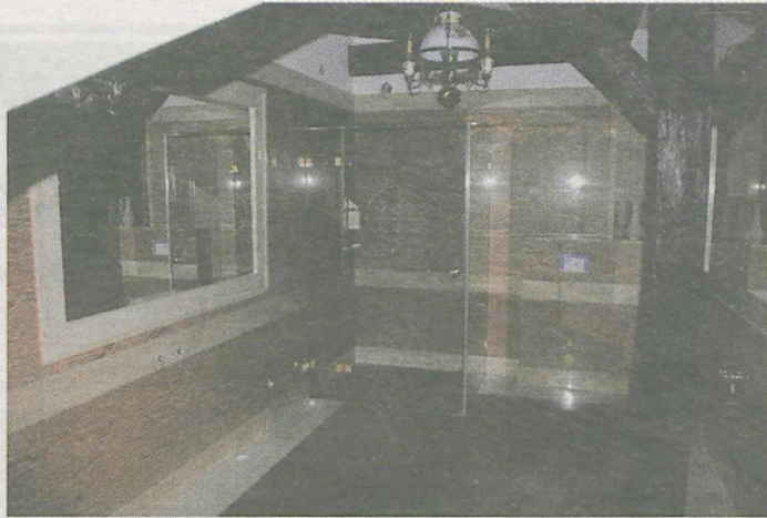
Trwa urządzenie łazienek przy apartamentach.
