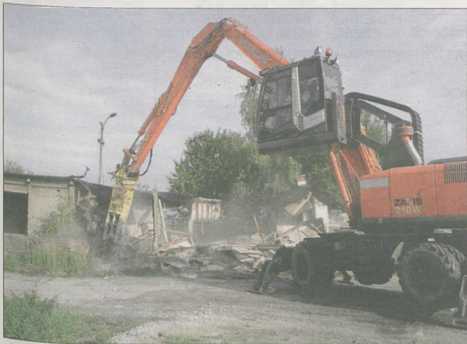
ROZBIÓRKA DAWNEJ WYTWÓRNI betonu rozpoczęła się w miniony czwartek. Wyburzenie jednego budynku, przy użyciu specjalistycznego sprzętu, zajęło zaledwie 15 minut
