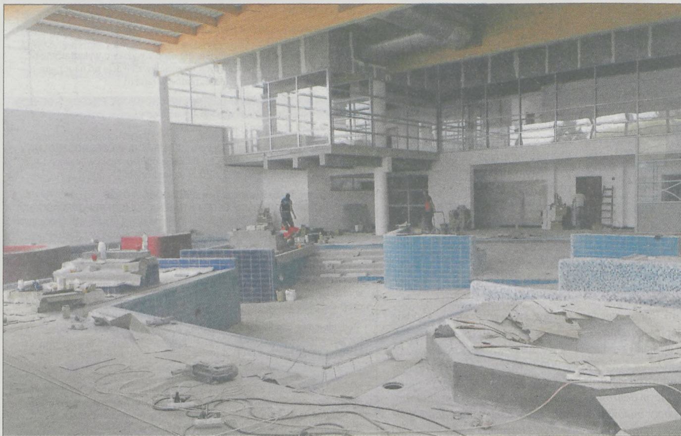
BUDOWA AQUAPARKU ma się potrwać do końca września
