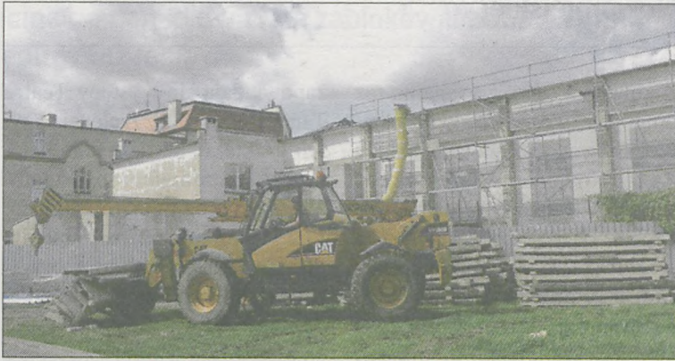
DEMONTAŻ DACHU rozpoczęto w miniony wtorek
