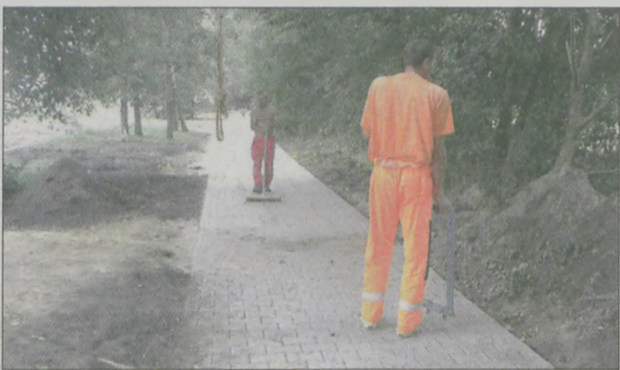
W UBIEGŁYM TYGODNIU kończono prace przy układaniu chodnika do strzelnicy
