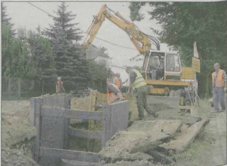
BUDOWA PRZYŁĄCZA KANALIZACJI DESZCZOWEJ spowodowała wyłączenie z ruchu części ul. Maratońskiej
