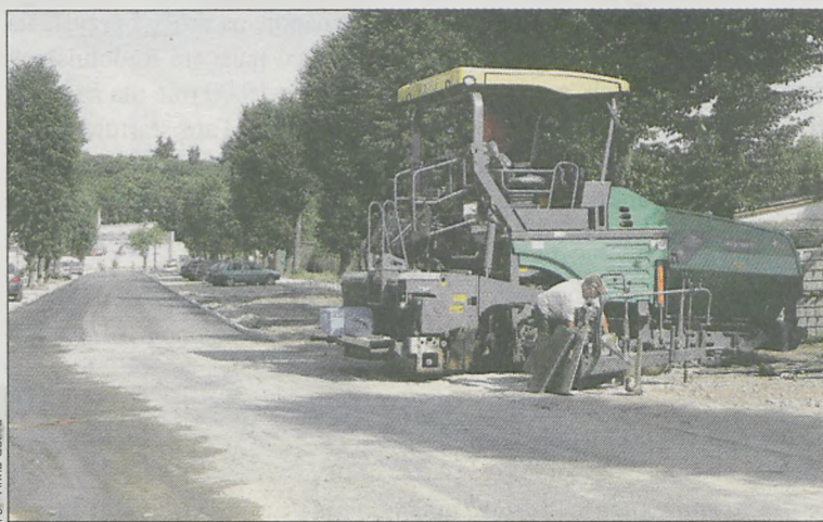
NA UL. SPORTOWEJ wykonane zostały zjazdy i chodniki z kostki brukowej. Na jezdni o długości 200 m położono pierwszą warstwę asfaltu
