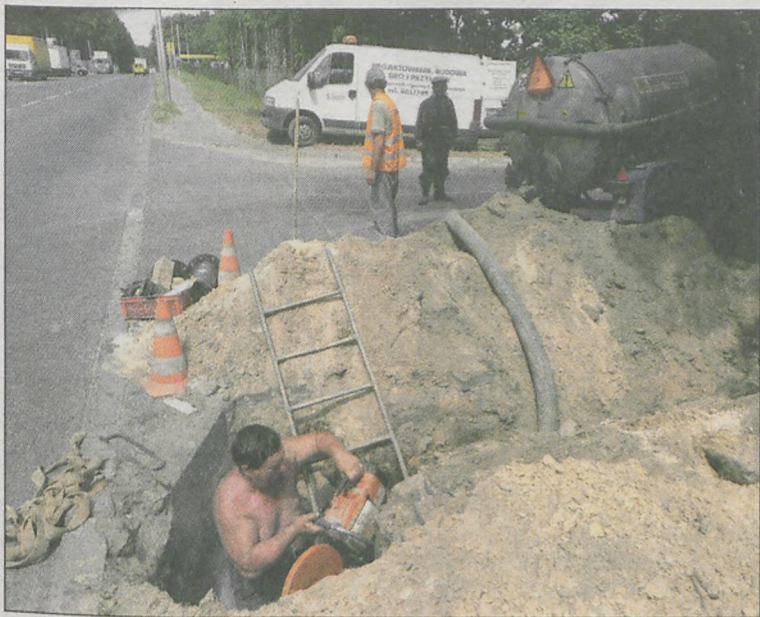
W CZWARTEK FIRMA DROBUD, na zlecenie PWiK-u, rozpoczęła budowę przyłączy wodociągowego do działek przy ul. Poznańskiej
