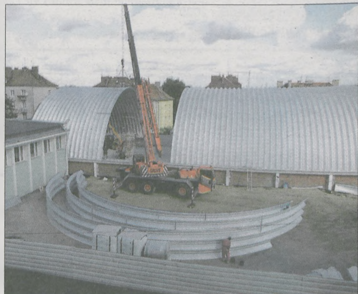
HALA PRZY „CZWÓRCIE” budowana jest w konstrukcji tukowej. W minionym tygodniu skończono montowanie dachu
