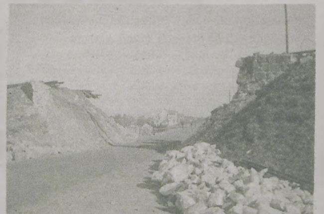
Wiadukt kolejowy w Ciświcy - 3 IX 1939 r.
