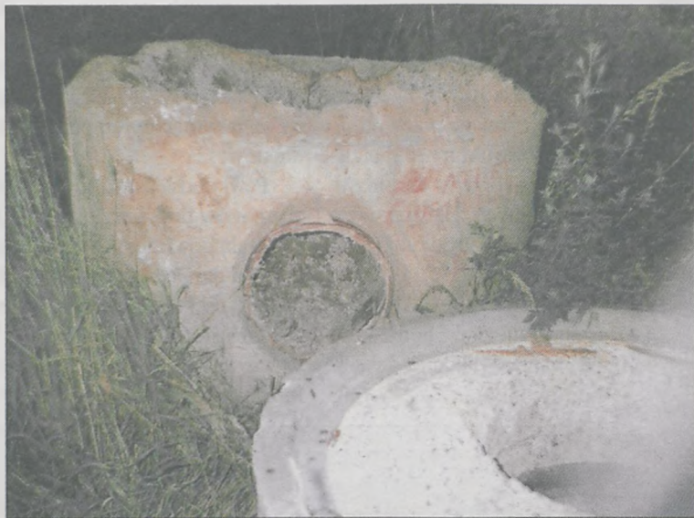
TAK WYGLĄDAŁY ELEMENTY dotychczasowej kanalizacji po ich zdemontowaniu
