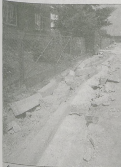
ZŁE ZAMONTOWANE KRAWĘŻNIKI wykopano i ułożono od nowa
