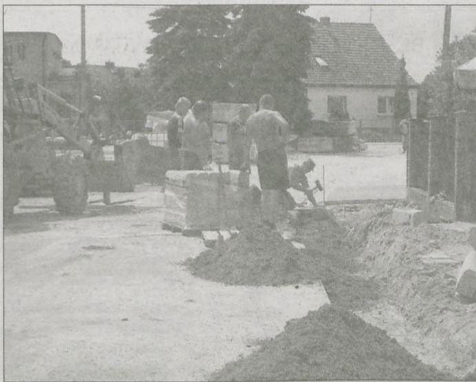
ZŁE ZAMONTOWANE KRAWĘŻNIKI wykopano i ułożono od nowa
