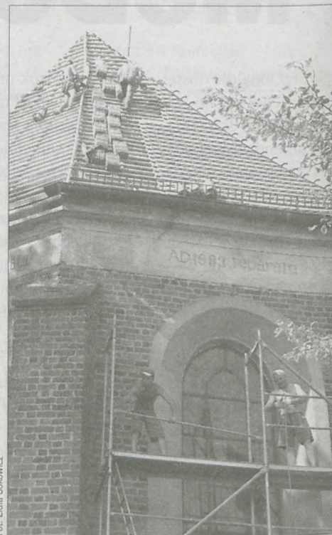
REMONT DACHU na nowomiejskim kościele potrwa jeszcze co najmniej dwa tygodnie
