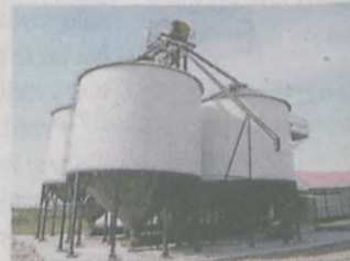
Linie technologiczne magazynów zbożowych
