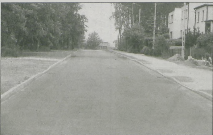
NA UL. NORWIDA wykonanych zostało ok. 600 metrów nawierzchni
