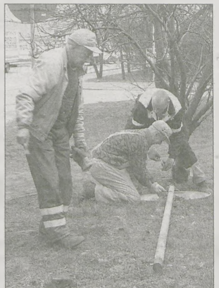
PRACOWNICY FIRMY Nadzory Konserwacja Dróg Wiesława Kowalska z Jarocina usunęli znaki zakazu wjazdu w Wodną
