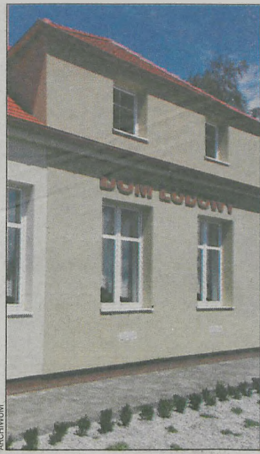
Między innymi ocieplono ściany budynku
