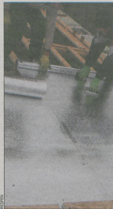
Montaż izolacji onduline onduterm
