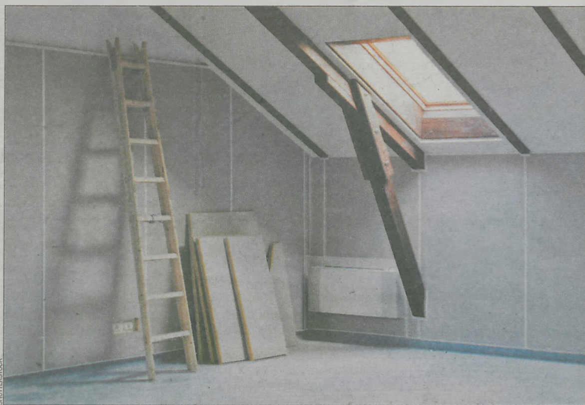
Płyty gipsowo-kartonowe można przyklejać zaprawą klejową względnie osadzać na stelażu stalowym lub drewnianym
