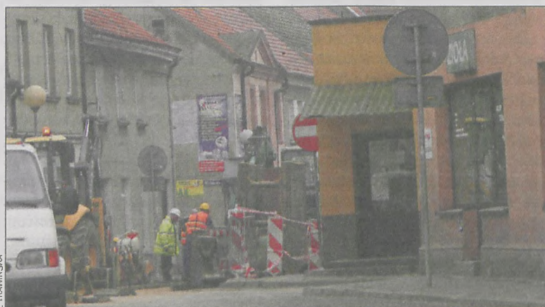
Na ul. Kościuszki prowadzony jest remont kanalizacji
