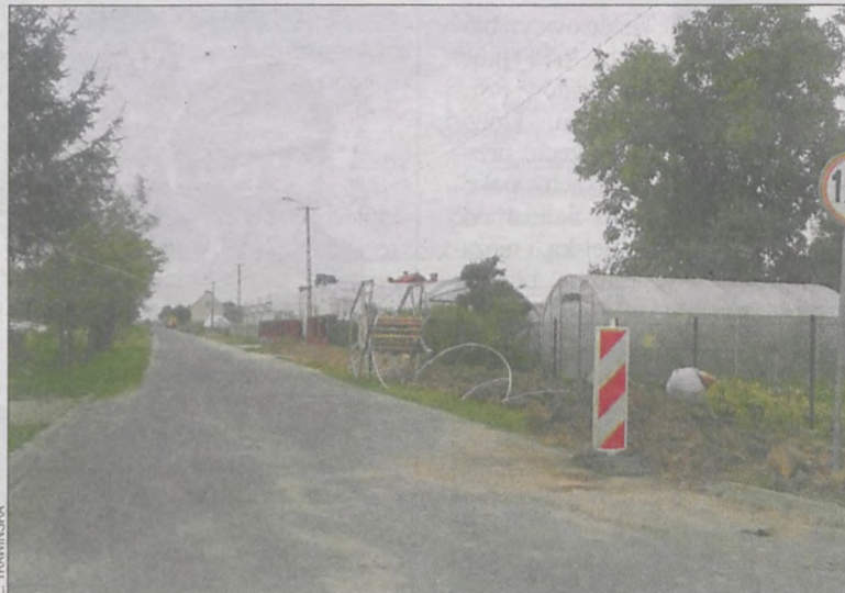
Podczas zakładania światłowódów w Gościejewie wzdłuż drogi powiatowej rozebrano nowy chodnik
