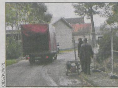
Prace ruszyły w połowie października
