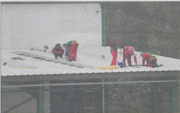
Montaż hali powoduje hałas, który przeszkadza lokatorom pobliskiego bloku
