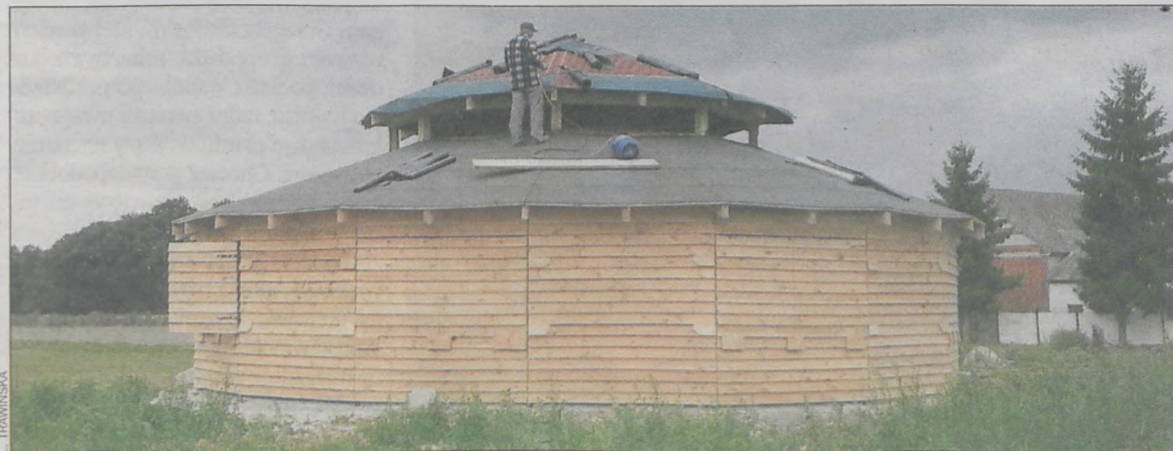
Prace przy budowie grzybka powoli dobiegają końca
