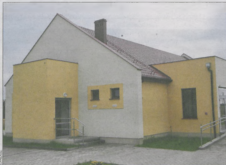
Tak wygląda gotowy budynek w Ujeździe
