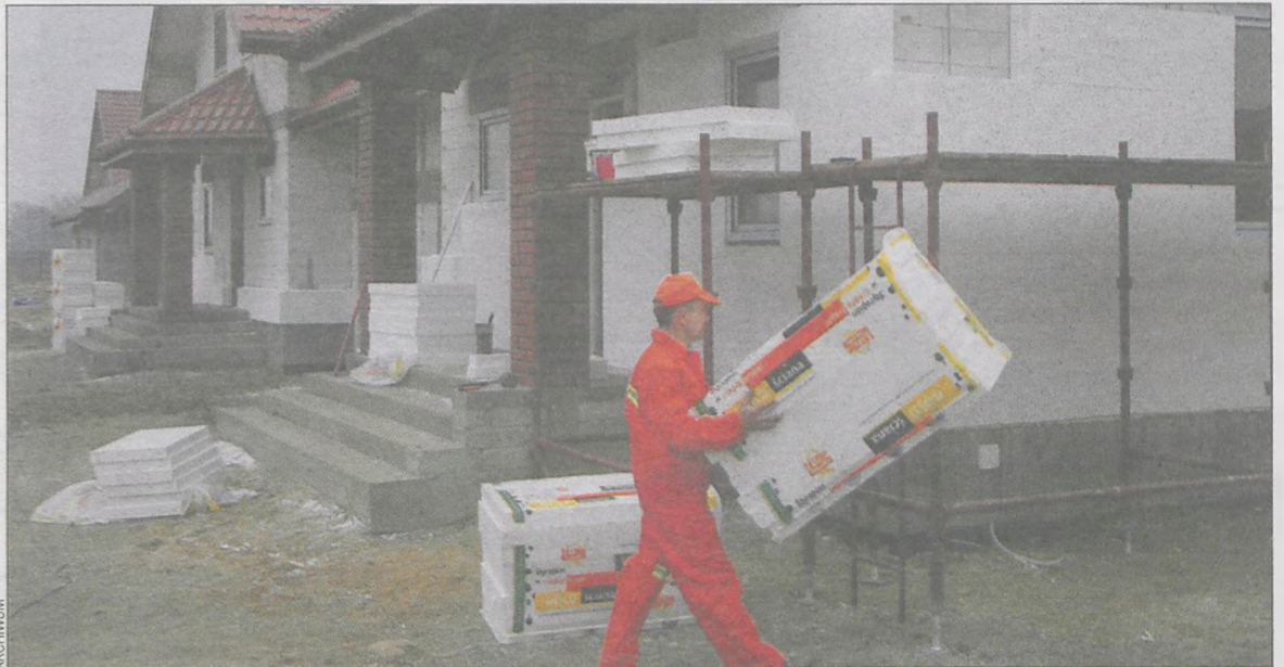
Po ociepleniu styropianem przychodzi czas na wybór warstwy zewnętrznej
