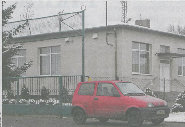
Do października prowadzony będzie remont sali w Smolicach. Zdjęcie z zimy 2014 r.
