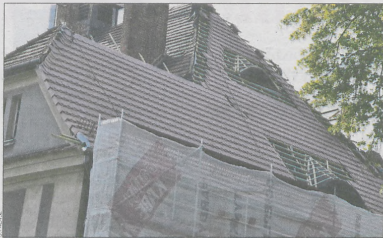
Wymiana dachu potrwa do września
