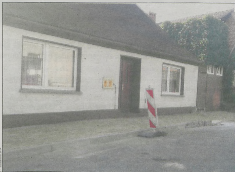
Wymiana nawierzchni chodnika na ul. Glinki
