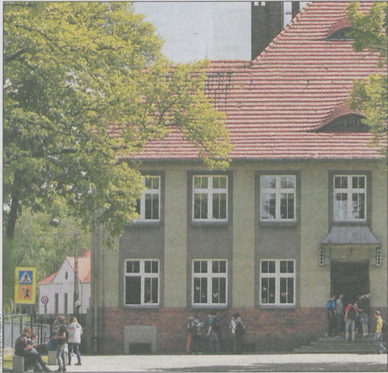
Całkowita wymiana dachu ma ruszyć zaraz po przetargu
