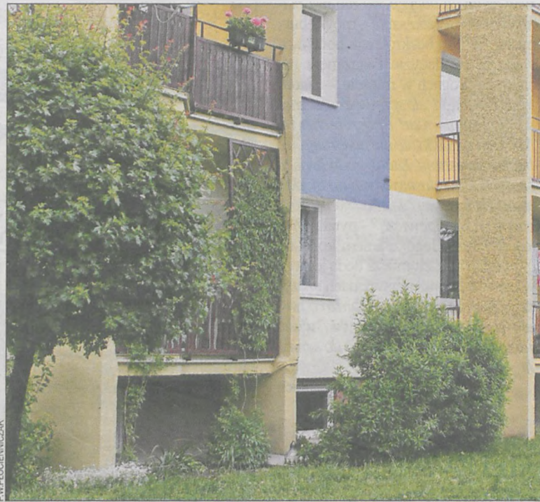
31-latek wypadł z drugiego piętra tego budynku
