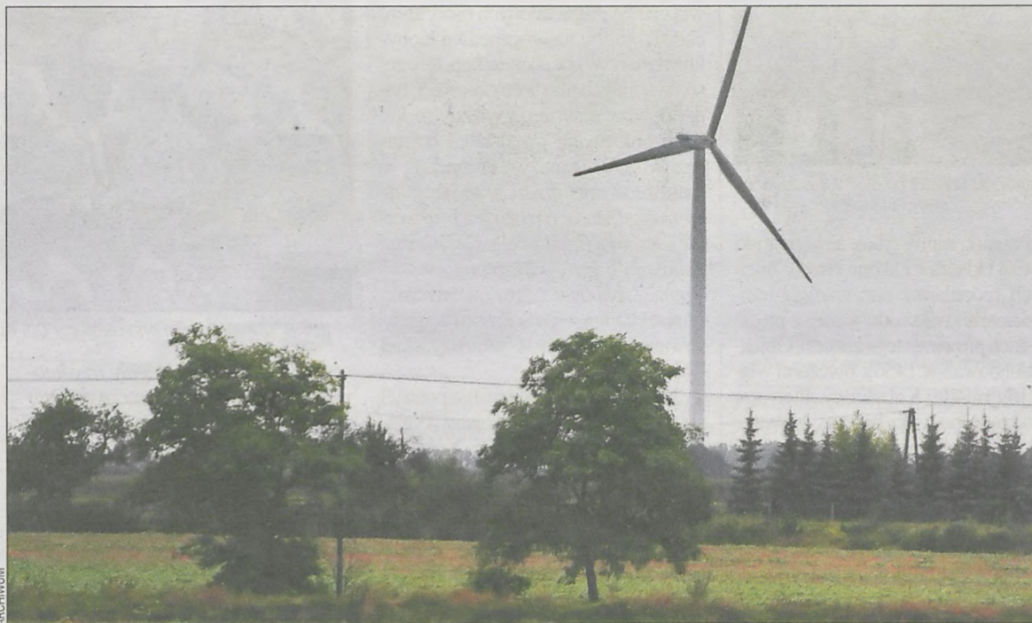
W kwietniu rozpoczęto budowę trzech wiatraków
