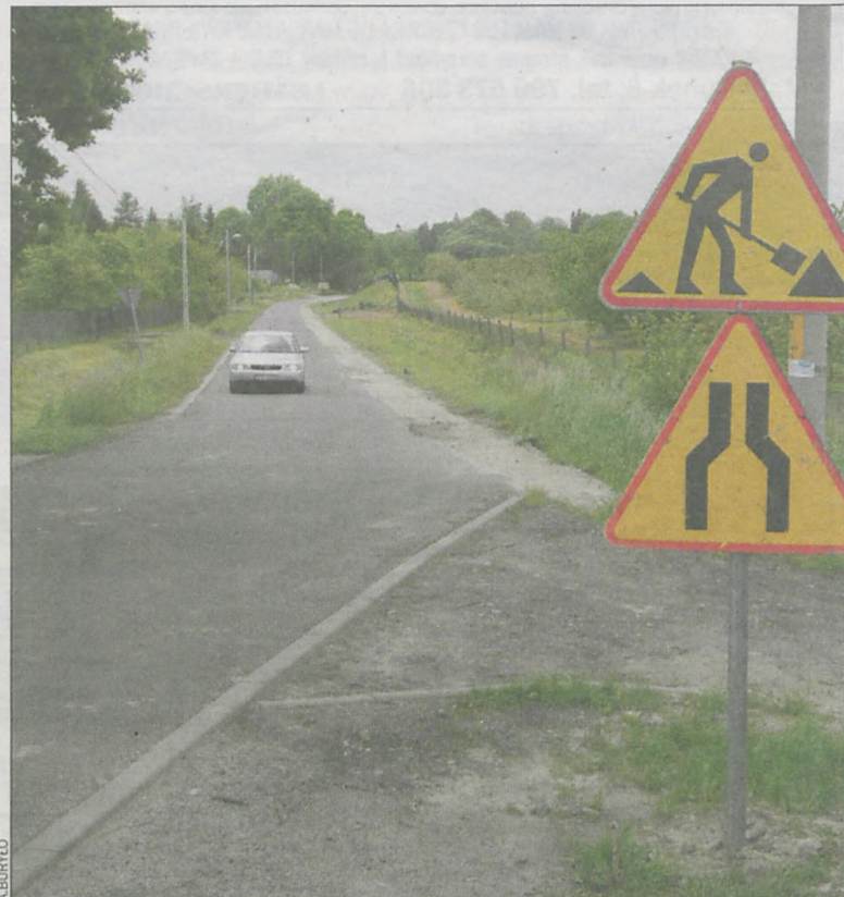
Pracownicy firmy Gembiak-Mikstacki mieli poszerzyć drogę do Raszowic. Podczas prac ruch samochodowy nie był wyłączony
