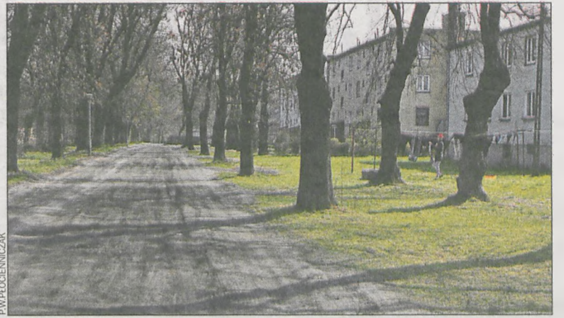
Remont nawierzchni będzie możliwy dopiero w 2015 roku
