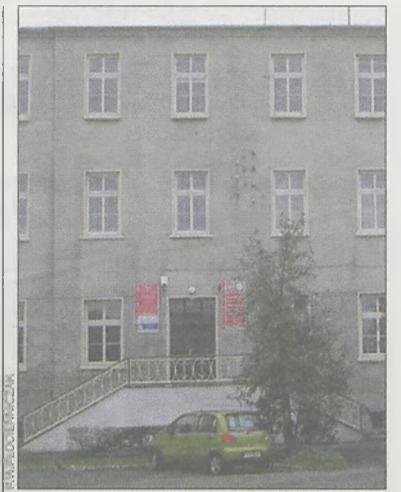
Budynek urzędu zyska nowy dach
