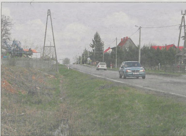
W Cieszkowie także wyczyszczono rowy i wykonano konserwację drenów
