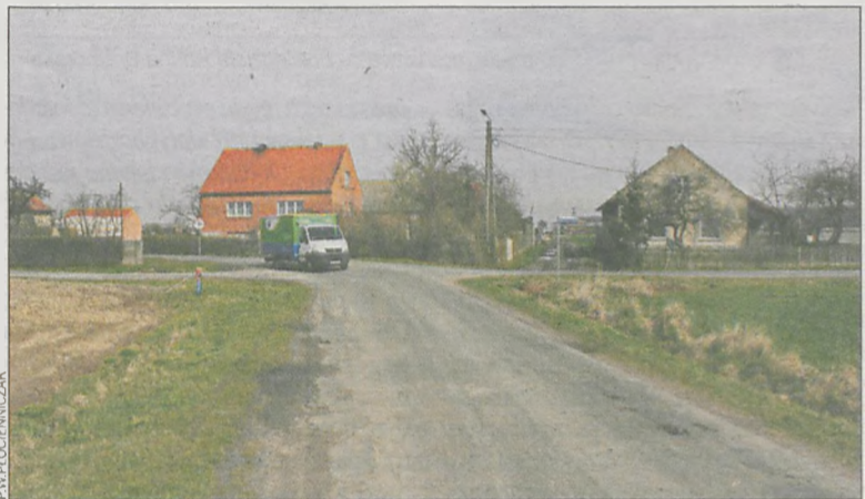
Źle wyprofilowana droga w tym miejscu stanowi niebezpieczeństwo dla kierowców
