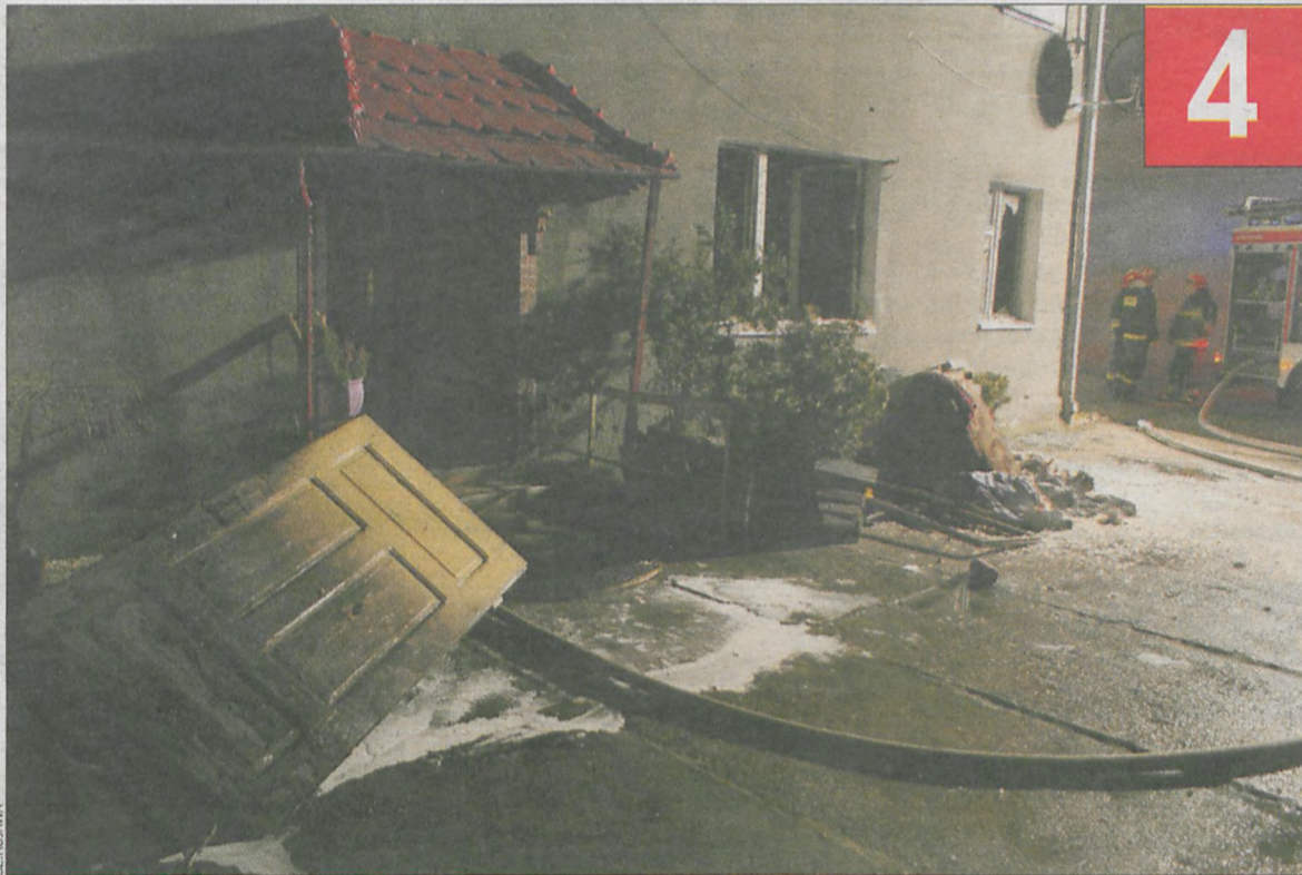
Lokatorzy uciekający przez klatkę schodową słyszeli krzyki zamkniętego w płonącym mieszkaniu 58-lata
