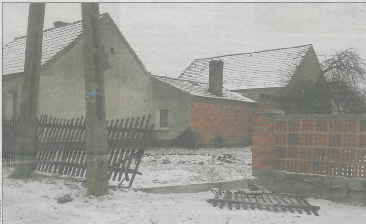
Zniszczony płot w Mokronosie to efekt kolizji spowodowanych śliską drogą
