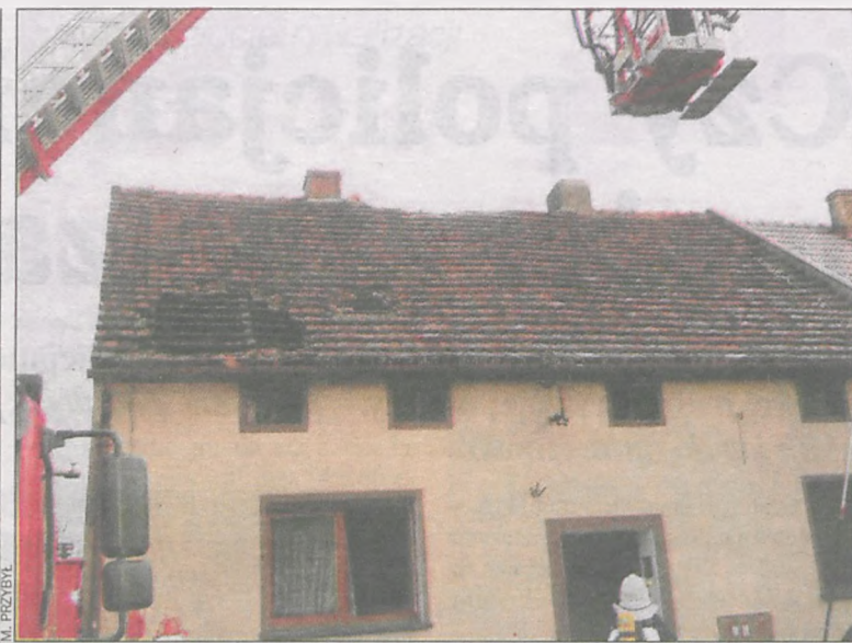
Budynek został zniszczony w środku i na zewnątrz
