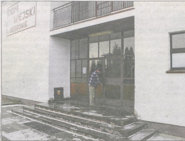
W świetlicy zostanie wymienione ogrzewanie
