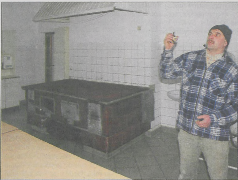
Najważniejszym elementem remontu świetlicy będzie montaż c.o.
