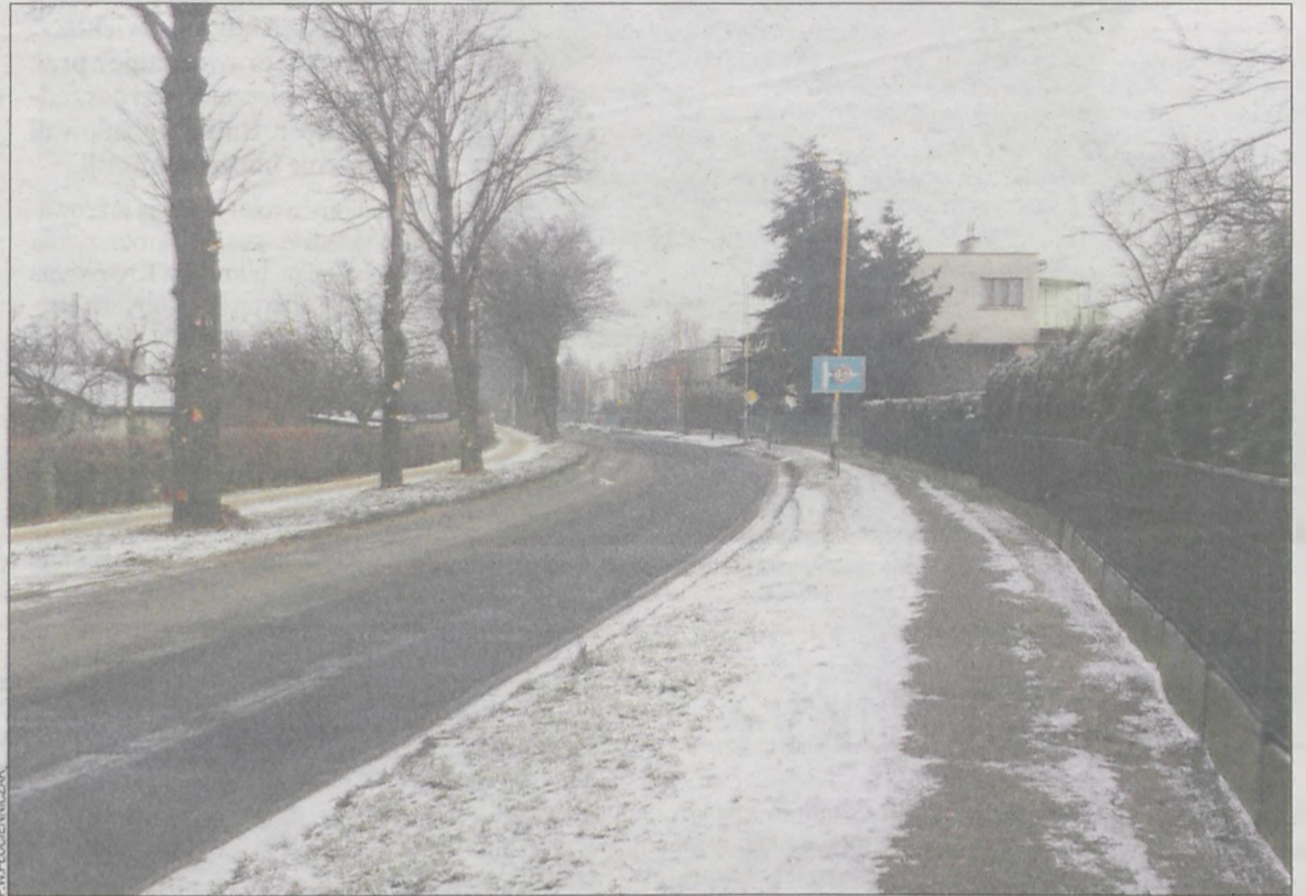
Zakończenie prac kanalizacyjnych zaplanowano na 2015 r.
