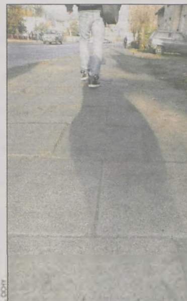
Tak chodnik wyglądał przed remontem
