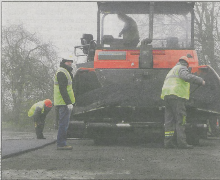
Kończy się remont 183 metrów drogi. Pozostało jeszcze 277 m
