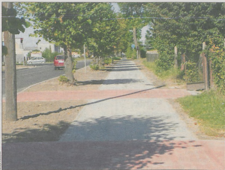
Do tej pory zmodernizowano 240 m ulicy
