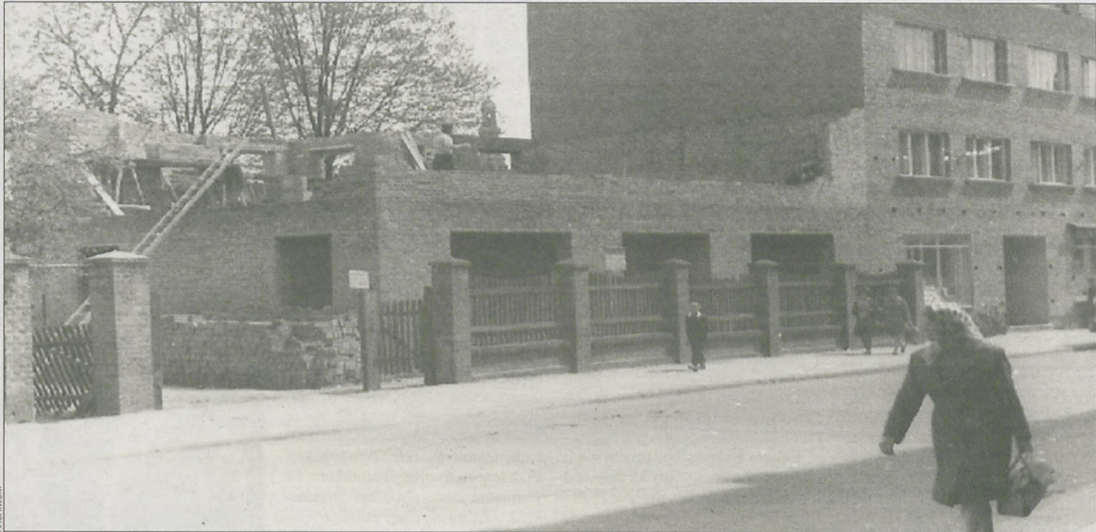
Rozpoczęcie budowy Domu Cechowego przy ul. Gen. Świerczewskiego (1962)
