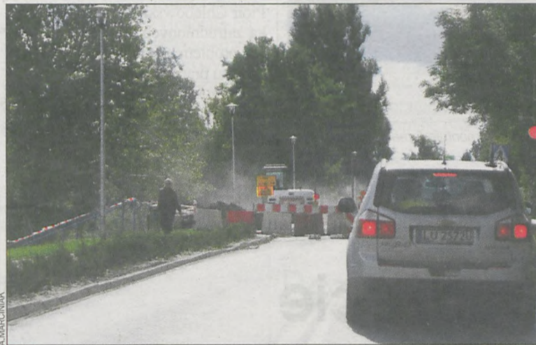
Prace na moście potrwają jeszcze kilka tygodni
