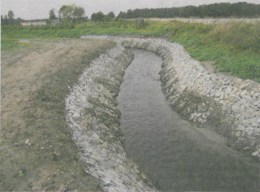
Umocnienie skarp cieku RJ gabionami (odcinek pomiędzy zbiornikiem suchych wód deszczowych nr 2 a nasypem kolejowym w miejscowości Osusz).
