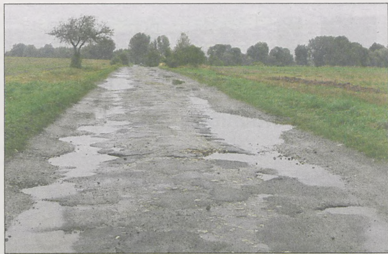
350-metrowy odcinek zostanie wkrótce zmodernizowany
