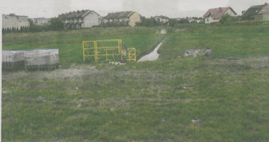
Prace porządkowe na suchym zbiorniku wód deszczowych nr 3 (przy ul. Okrężnej).
