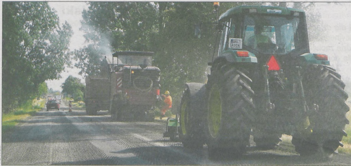
Remont drogi krajowej przesunął się na odcinki w Krotoszynie
