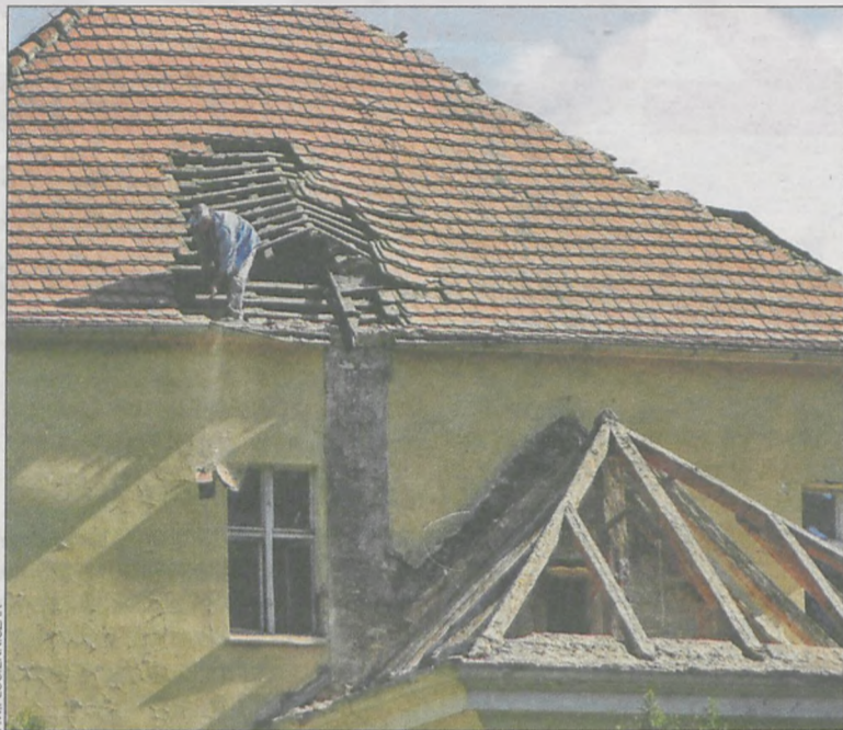
Trwa rozbiórka starego dachu
