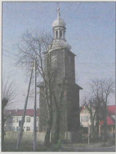
Zabytek czeka na gruntowną renowację
