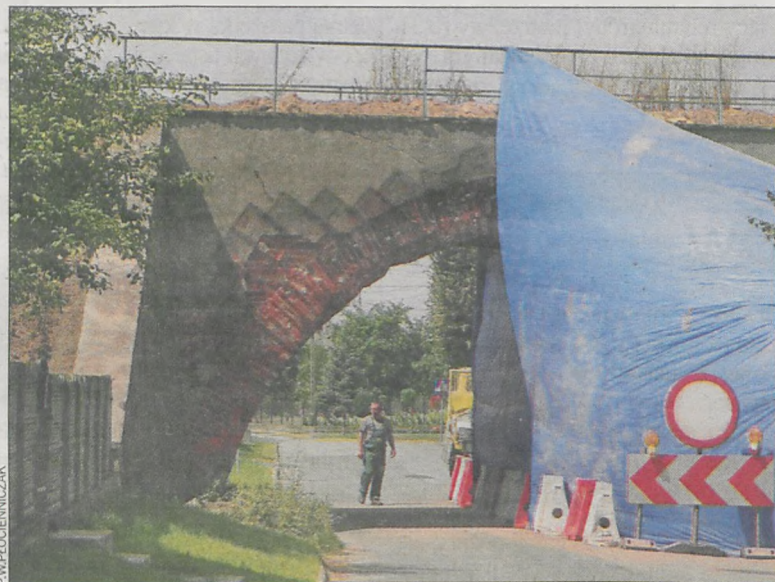
Renowacja wiaduktu potrwa do końca sierpnia
