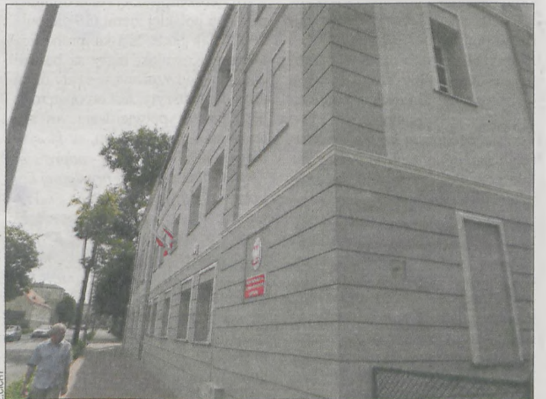
Budynek został ocieplony, a elewację odnowiono
