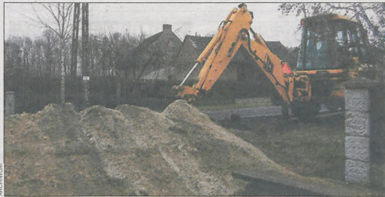
Kanalizacja w Krzekotowicach ma być gotowa w październiku
