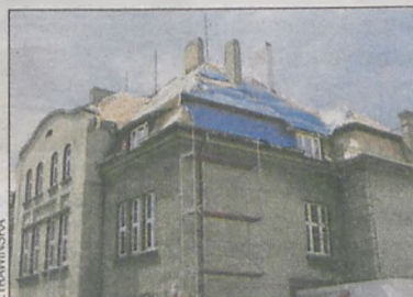
Prace na SP nr 3 nabierają tempa
