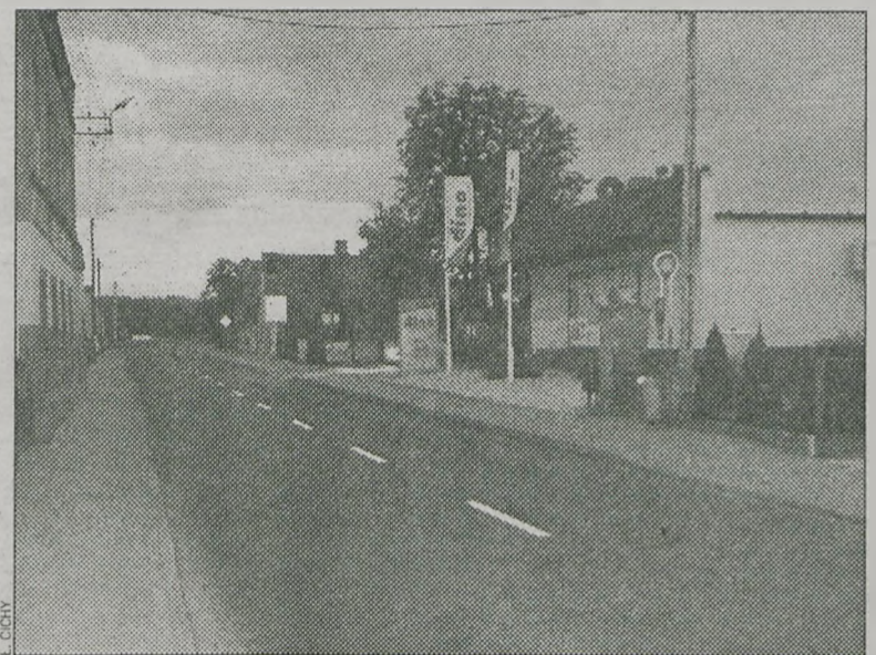
Na ul. Wrocławskiej przy „Dino” brakuje przejścia dla pieszych
