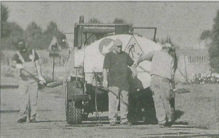
Prace na trasie Baszków – Kobylin
