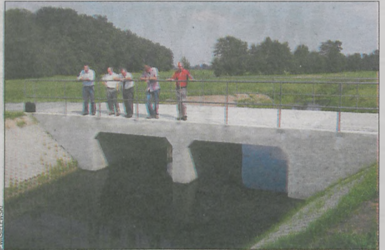
Przy okazji budowy mostu uregulowano rowy przy Radęcy
