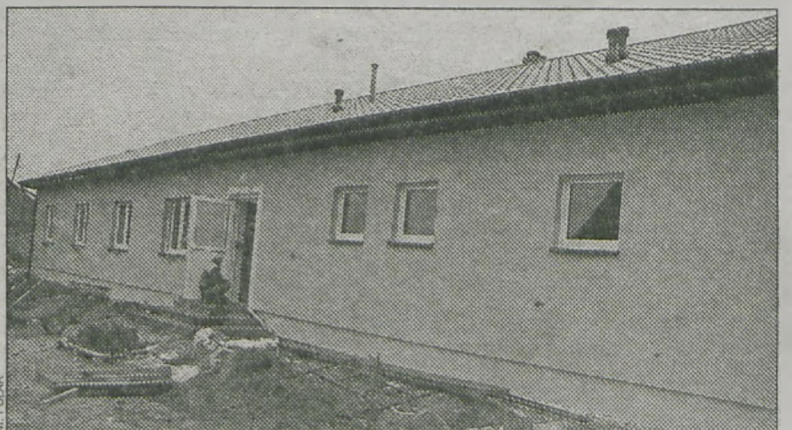
Stara część świetlicy została przerobiona na sanitariaty i kuchnię, natomiast część dobudowana będzie salą balową
