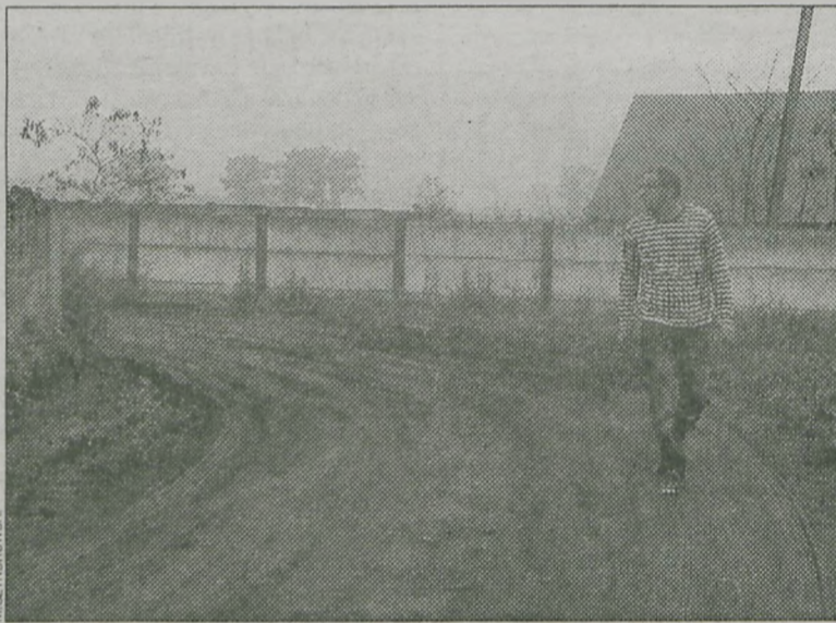
Droga rozjechana przez sprzęt budowlany ma zostać naprawiona
