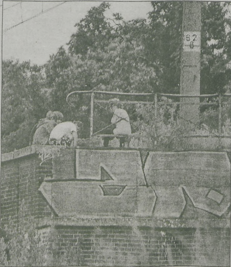
Na wale kolejowym przy ul. Rawickiej w Krotoszynie
