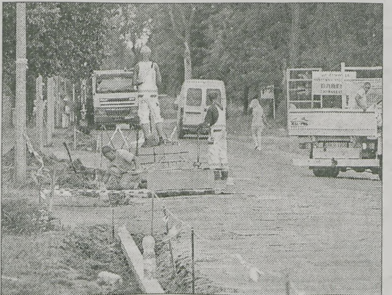
W tej chwili ekipa remontowa kładzie krawężniki przy jezdni
