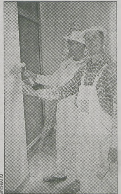
Mury już stoją, teraz prowadzone są prace wewnątrz budynku
