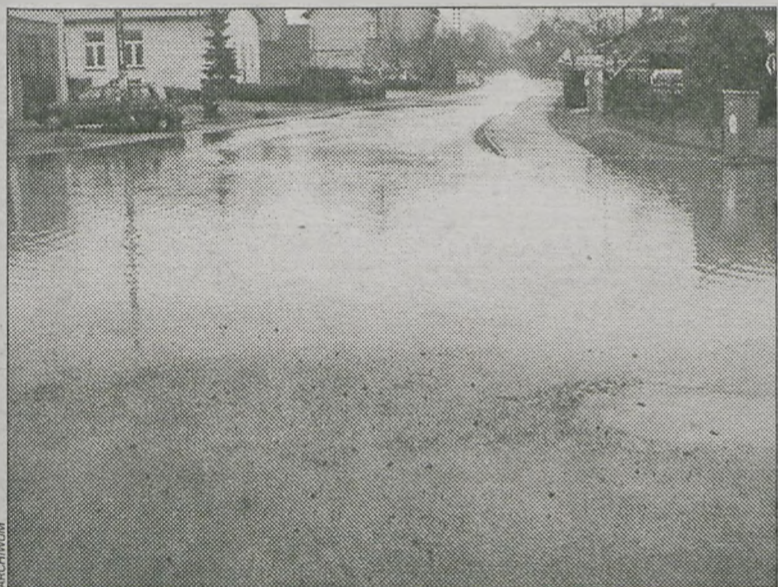
Grębowianie walczą o remont drogi zalewanej w czasie deszczów
