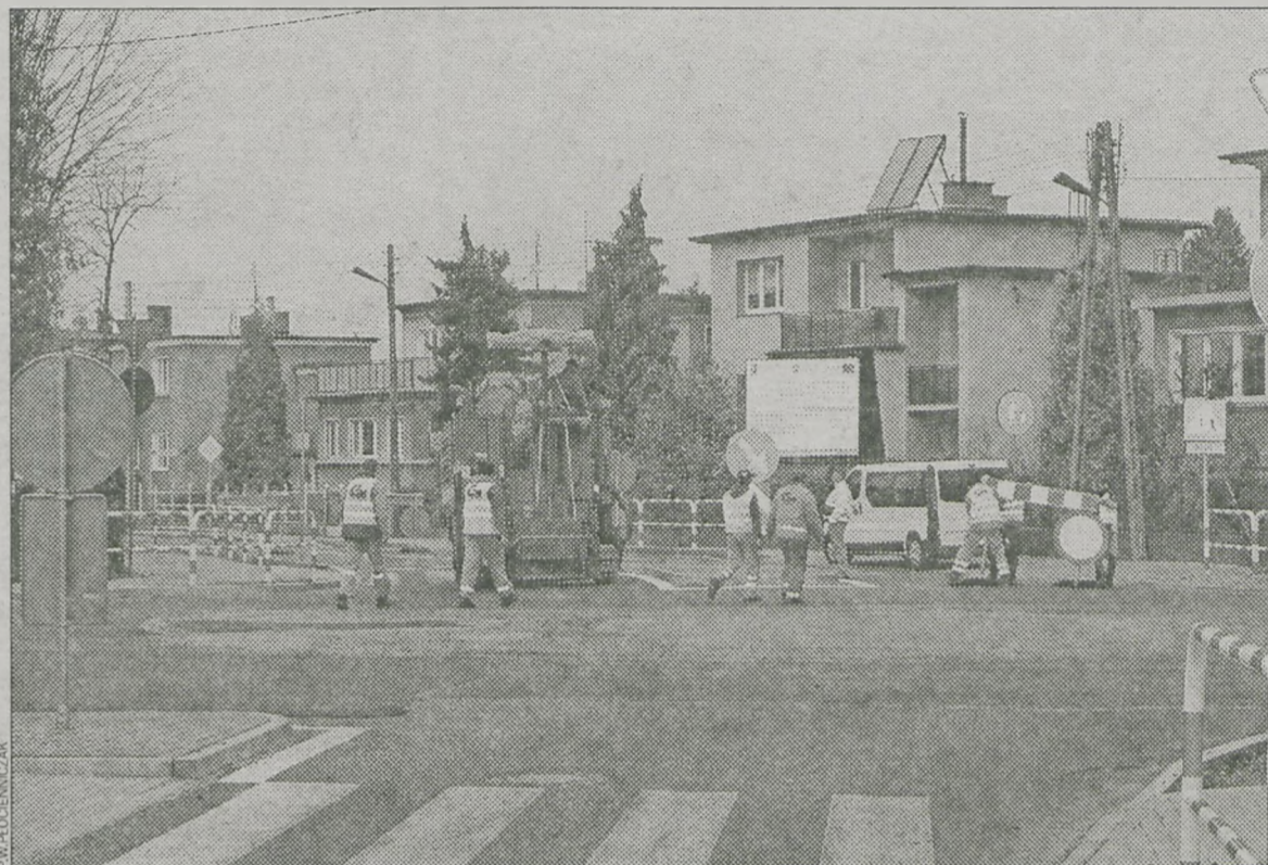
Krytyka ze strony mieszkańców spływa po dyrektorze PZD, jak woda po kaczcze. Jego zdaniem objazd został dobrze wytyczony
