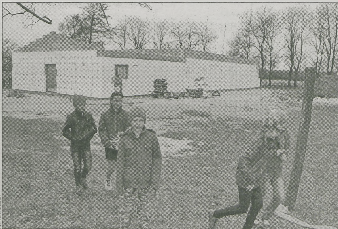
Prace budowlane stanęły już w styczniu. Nie wiadomo, kiedy zostaną wznowione
