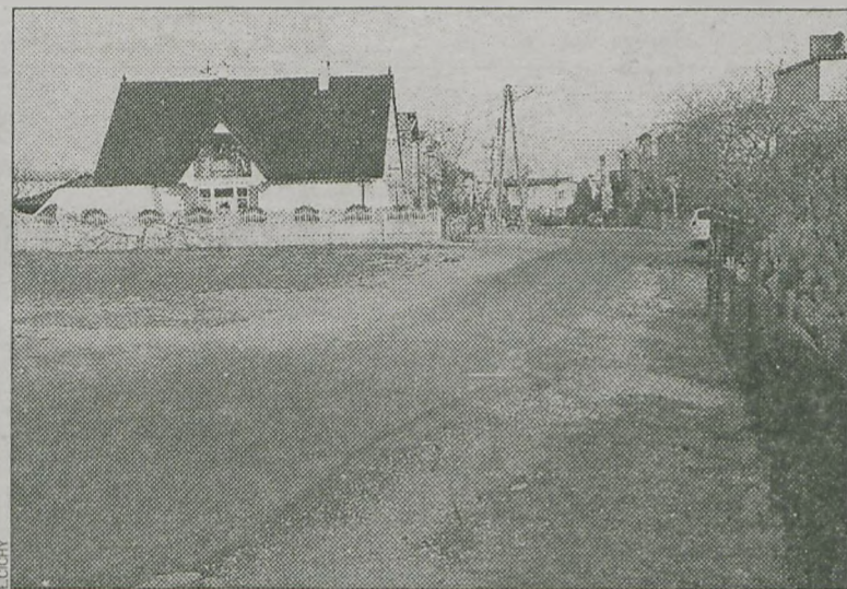
Przebudowana zostanie m.in. ulica Polna
