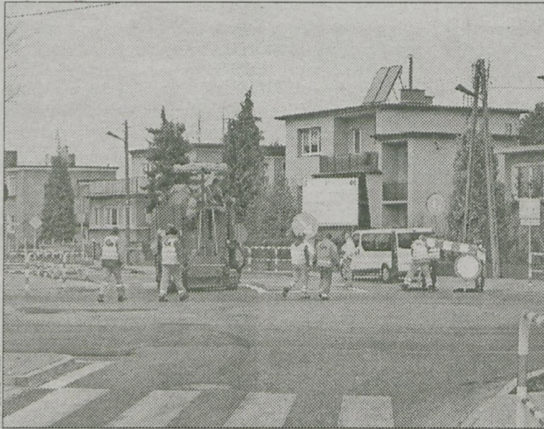
Wykonawcą inwestycji jest firma Gembiak-Mikstacki
