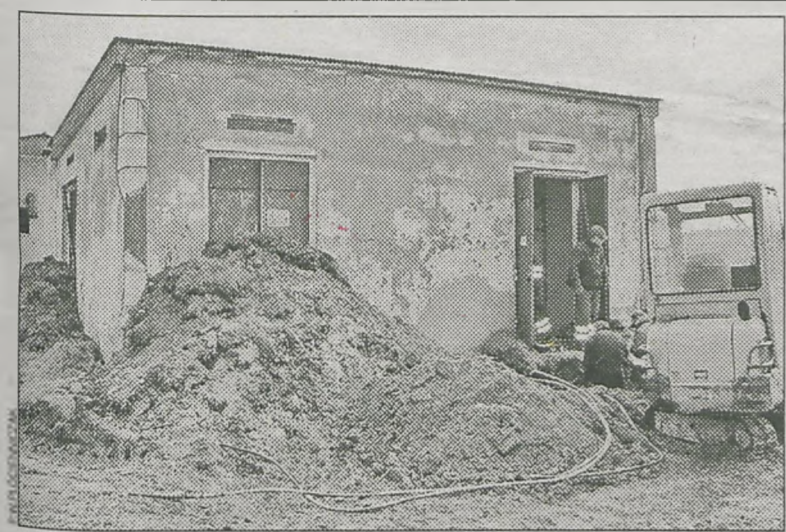
To nie pierwsza tragedia przy tej trafostacji
