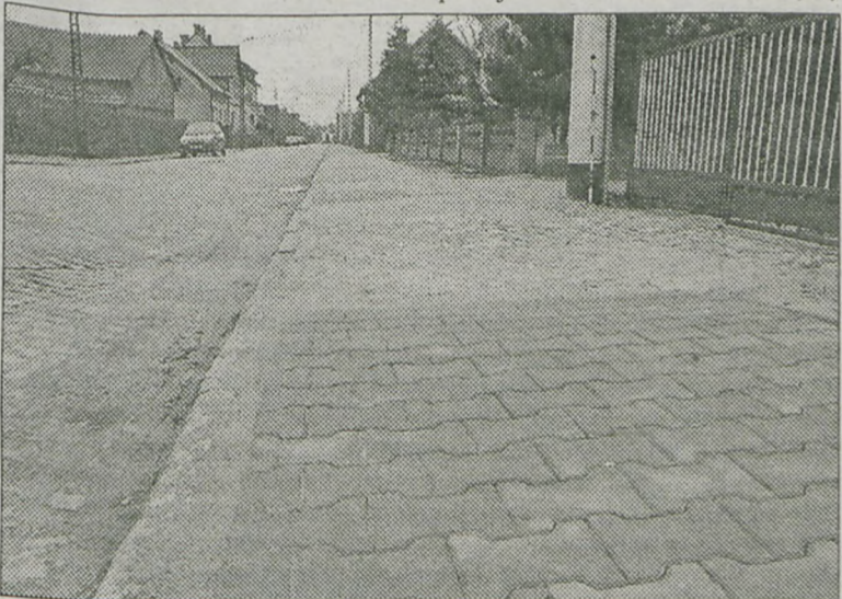
Zbudowali kanalizację, drogi i chodnik
