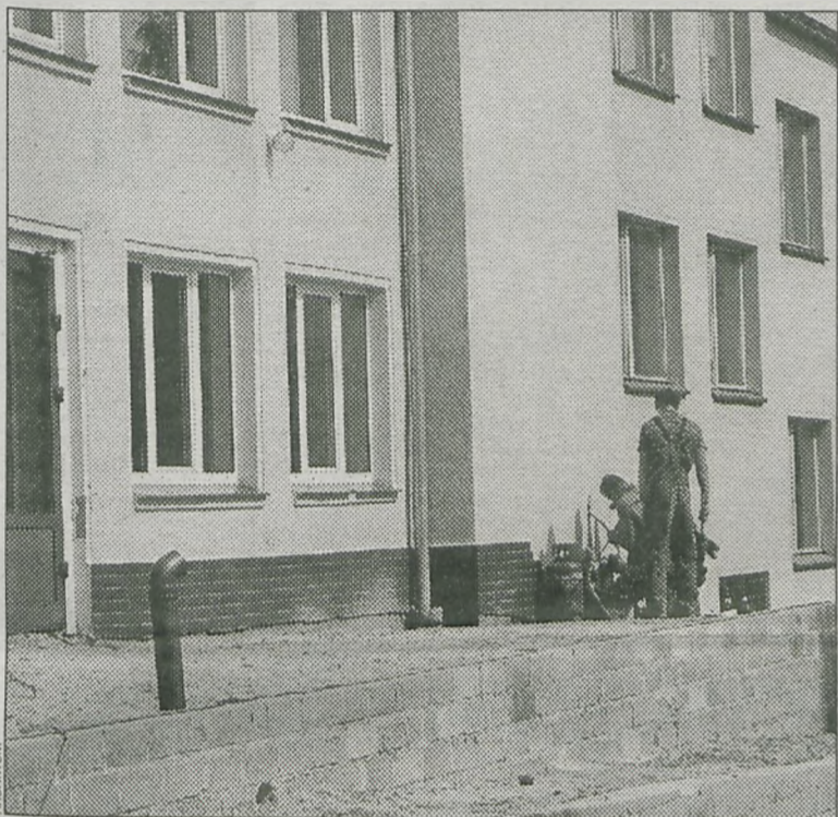
Gruntowną modernizację przeprowadzono w 2011 roku
