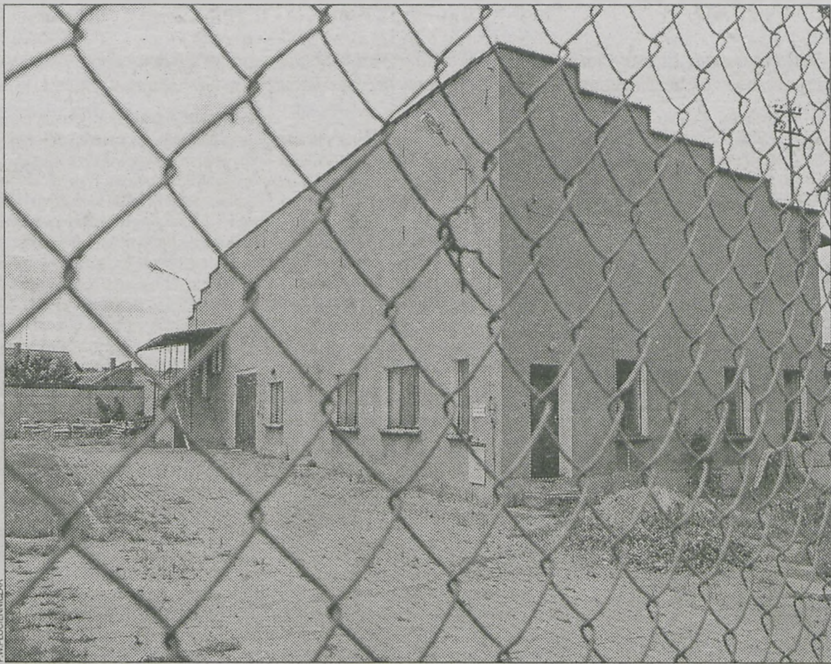
W tej chwili obiekt po gazowni jest w opłakanym stanie
