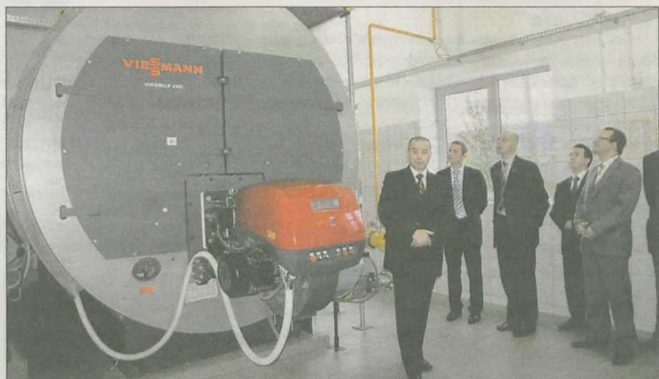
Obiekt po remoncie wzbogacił się o kotłownię gazową, mającą wspomagać dwa kotły węglowe
