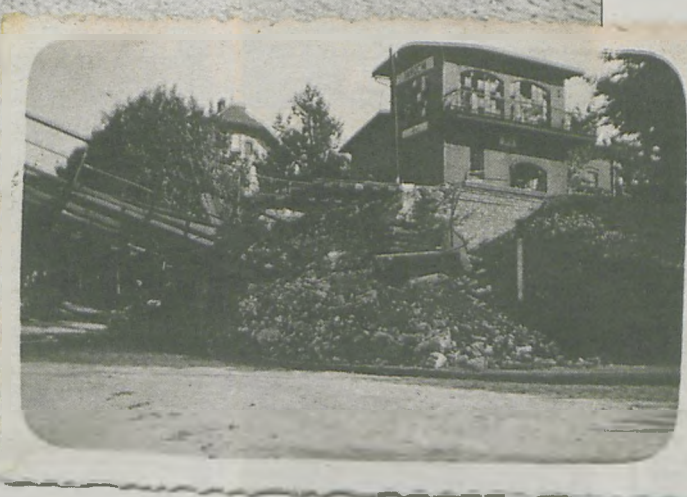
POLACY NISZCZYLI WIADUKTY KOLEJOWE, aby Niemcy nie mogli się dostać do Jarocina
